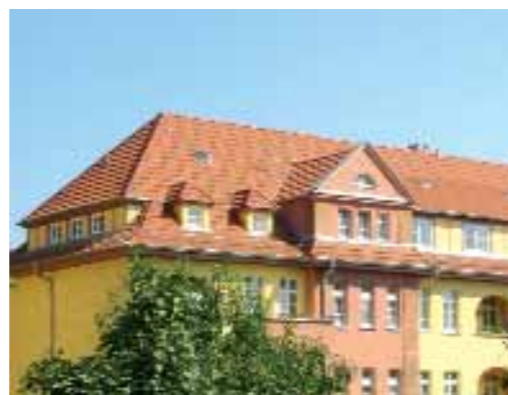
Hinteransicht der sanierten Teichstraße 7-9
