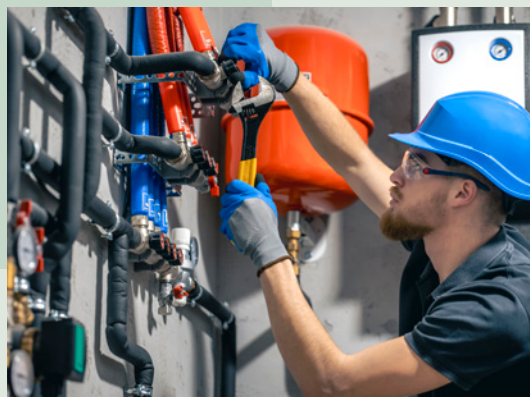
Steckling Sanitär & Heizung Lars Steckling
